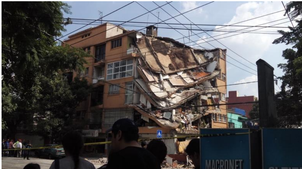
Figura 9. Derrumbe de departamentos. Centro de estudios demográficos urbanos y ambientales. 2017
