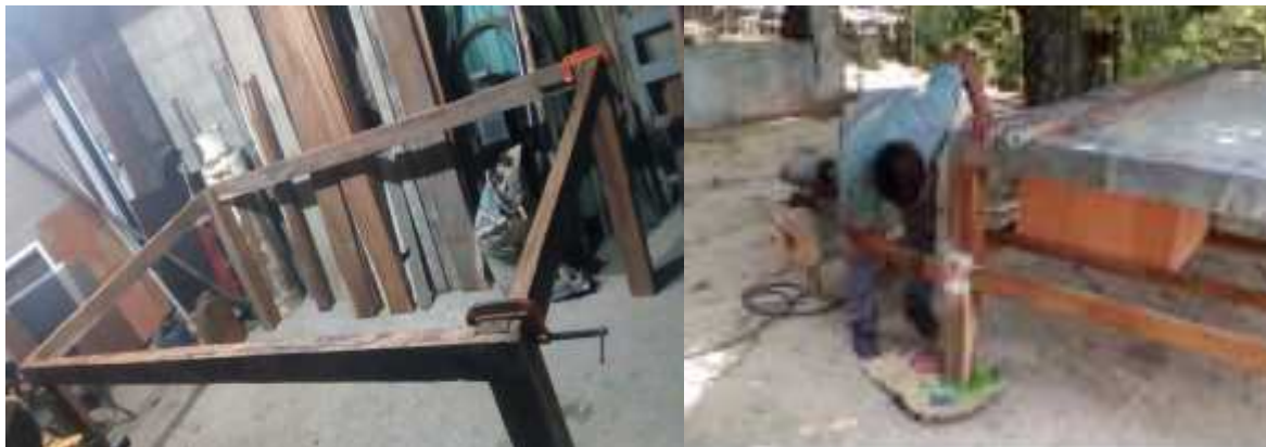
Ilustración 8, Construcción del prototipo de estación de trabajo. Fuente: Propia
